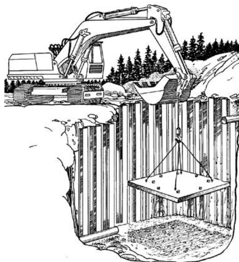
Рис. 42 Опускание фундаментной плиты
