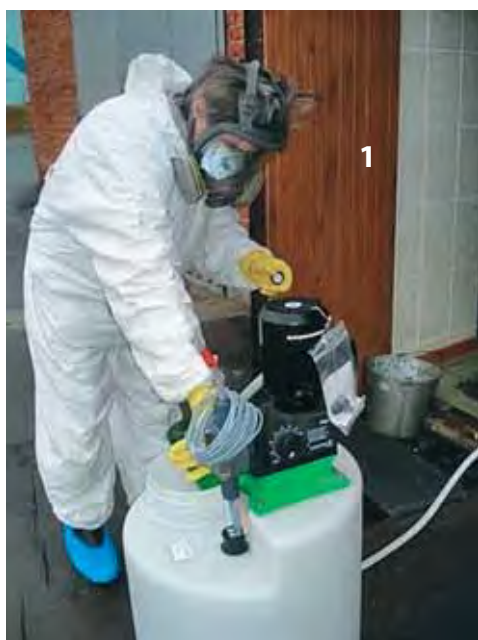
Рис. 99. Станция кислотной промывки электролизёра: 1 - для установки Selcoperm 195-125; 2 - для установок Selcoperm 195-5000 и 20000
