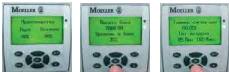
Рис. 96. Контроль установки Selcorperm 195-125 с панели управления.
