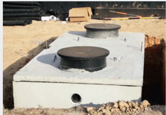
Рис. 3 Септик для приема сточных вод из домашнего хозяйства.
