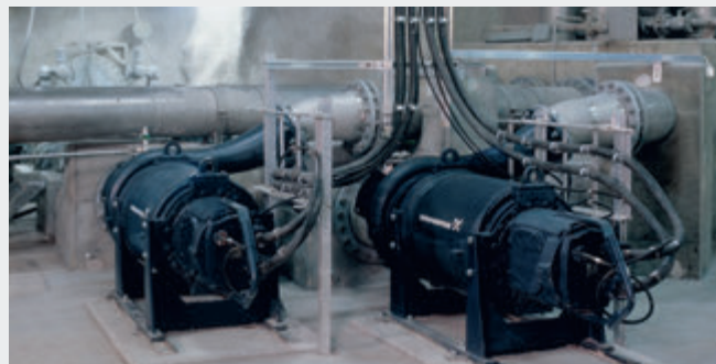
Рис. 13 Сухой горизонтальный монтаж погружного канализационного насоса Grundfos со стойками и скользящими направляющими.
