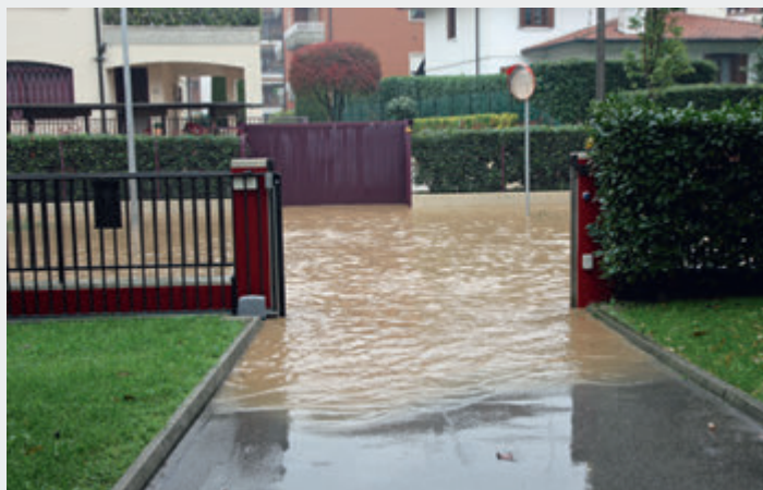
Рис. 4 Ливневые воды на дороге в поселке после обильных осадков.
