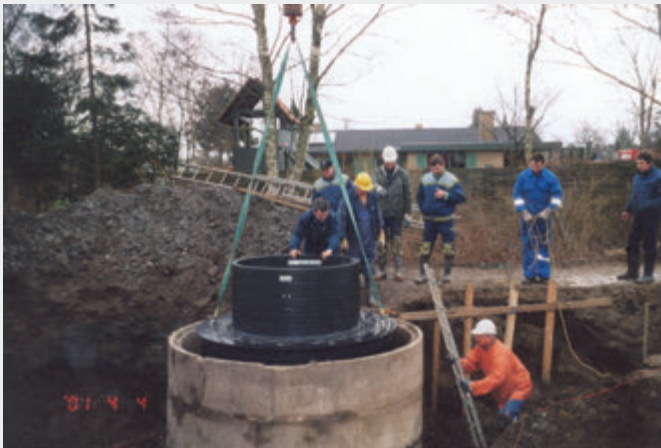
Рис. 46 Установка новой комплектной насосной станции, внутри старой бетонной конструкции.
