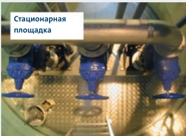
Рис. 21 Стационарная площадка обслуживания.
