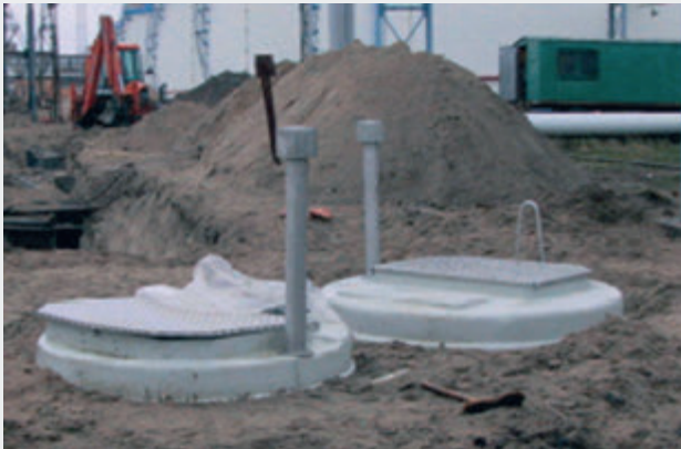
Рис. 36 Порт Вентспилс — крупнейший экспортный морской порт на Балтике. Здесь Grundfos установил готовую насосную станцию для перекачки нефтепродуктов.
