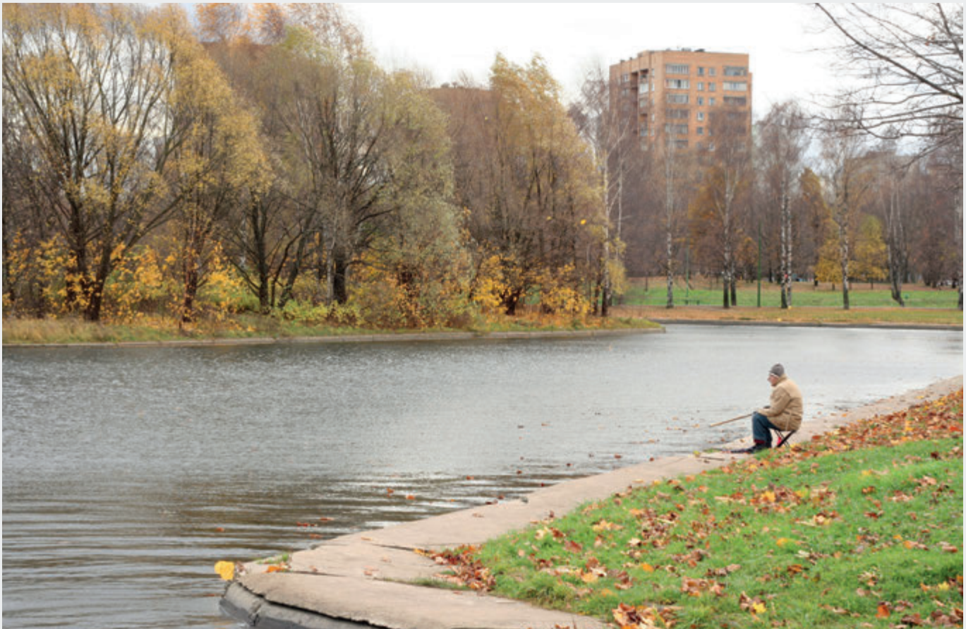
Рис. 5 Водохранилище для сбора ливневой воды и предотвращения затопления дороги после обильного выпадения осадков.
