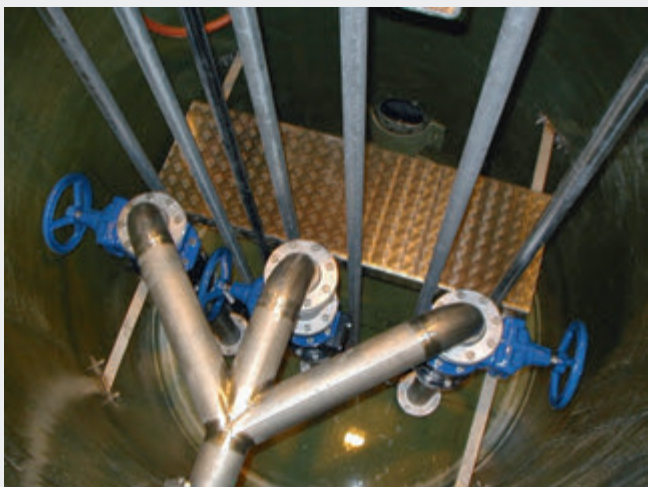
Рис. 20 Насосная станция с трубопроводной системой DC на три насоса и подъемной площадкой.
