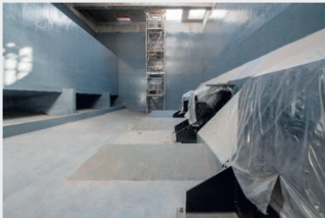
Рис. 10 Вид приёмного отделения после внесения изменений с рассекателем потока, разделителем потока ниже приёмной камеры и увеличенной глубиной с дополнительным уклоном для увеличения скорости в направлении насосов.
