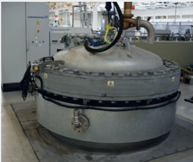
Рис. 4 Колодец для испытаний погружных осевых насосов серий KPL и KWM.
