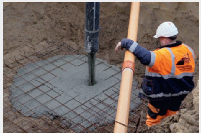
Рис. 14 Заливка бетонной плиты на месте монтажа.
