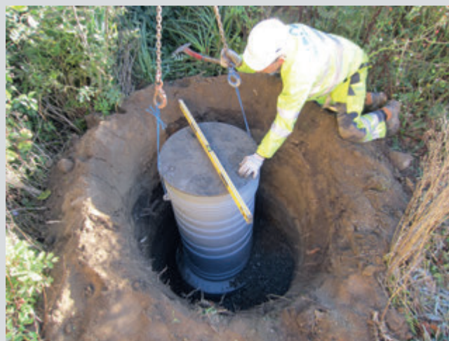
Рис. 4 Комплектная КНС Grundfos для напорных наружных систем канализации.
