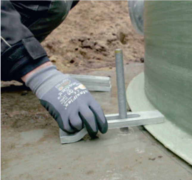
Рис. 18 Установка монтажных кронштейнов.
