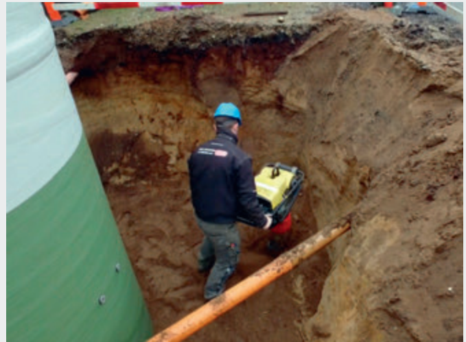
Рис. 19 Уплотненные слои толщиной не более 50 см.
