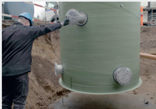
Рис. 16 Опускание резервуара.
