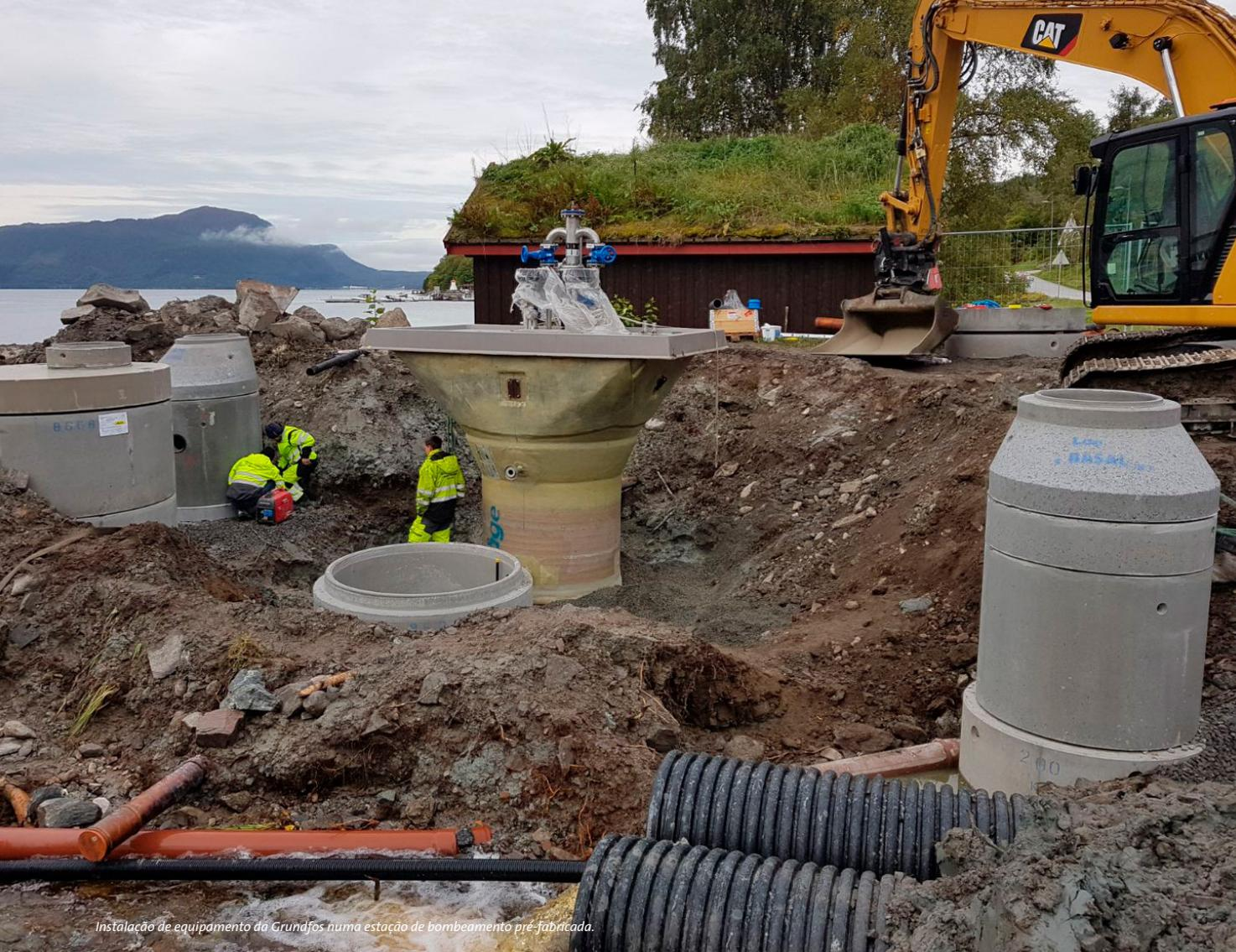
Instalação de equipamento da Grundfos numa estação de bombeamento pré-fabricada.
