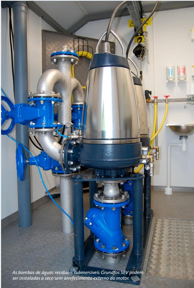
*As bombas de águas residuais submersíveis Grundfos SEV podem ser instaladas a seco sem arrefecimento externo do motor.*
