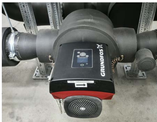
Wysokowydajna pompa liniowa z serii TPE
