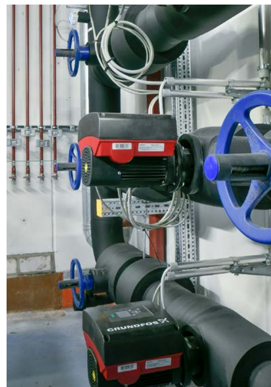
Pompy zimnej wody do pompowania czynnika zimnego do dystrybutora Zortström
