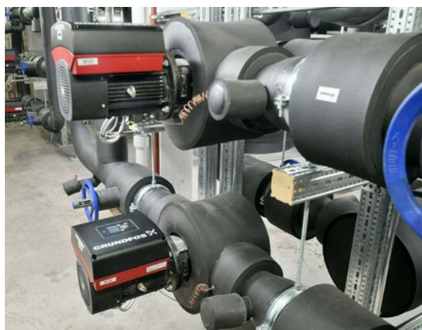
Regulowane elektronicznie pompy chłodnicze firmy Grundfos
