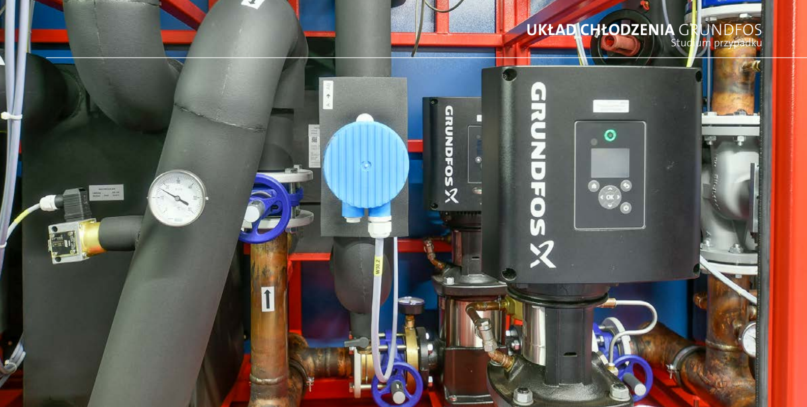
Grupa kształtek z wysokowydajnego układu odzysku ciepła SEW
