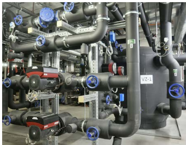
Nowe centrum zasilania z jednym z trzech dystrybutorów Zortström i pompami chłodniczymi
