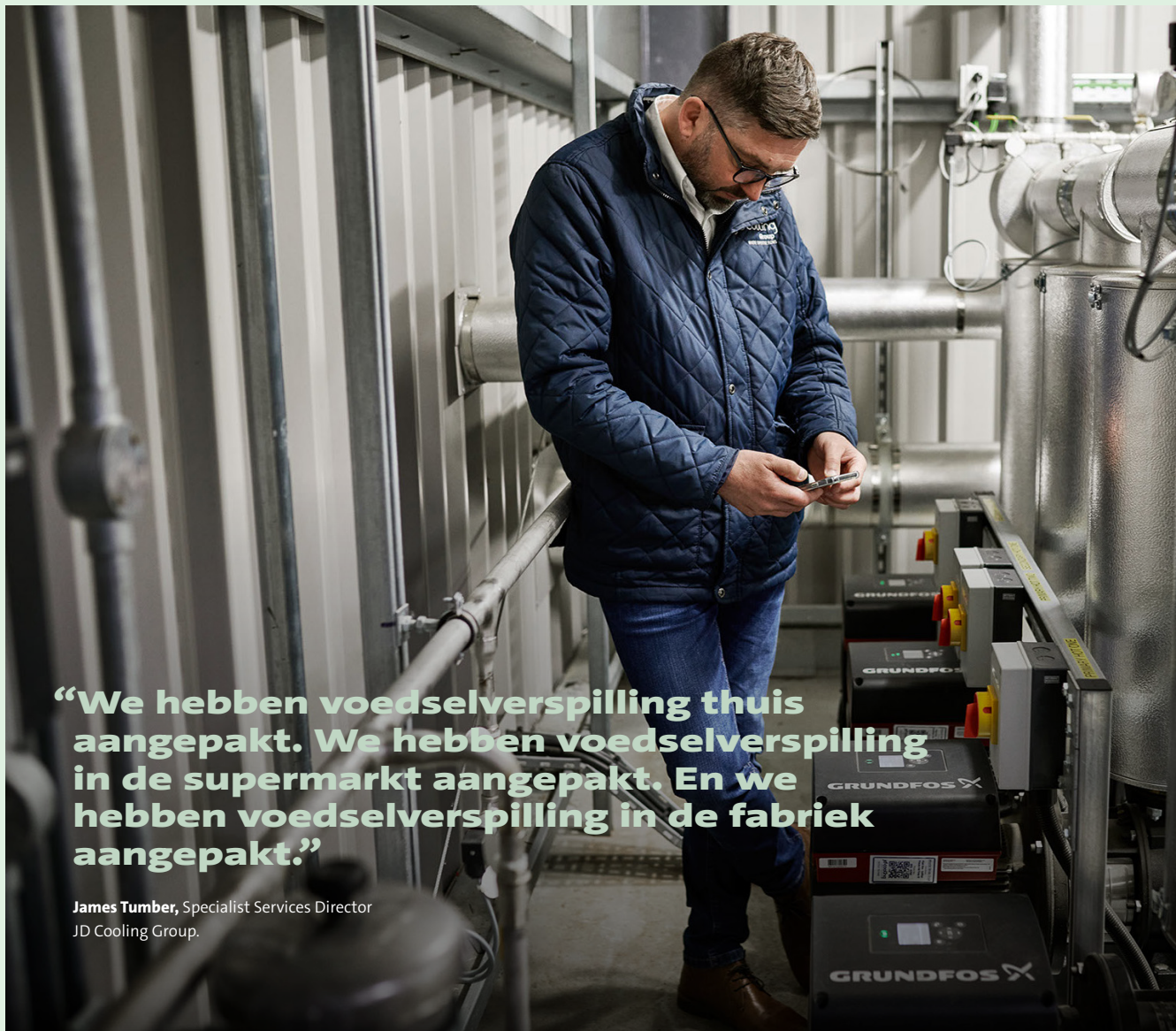
James Tumber gebruikt de app op zijn smartphone om de status van de Grundfos NBE-circulatiepompen te checken. Deze pompen voorzien het Softripe-systeem van glycol.
