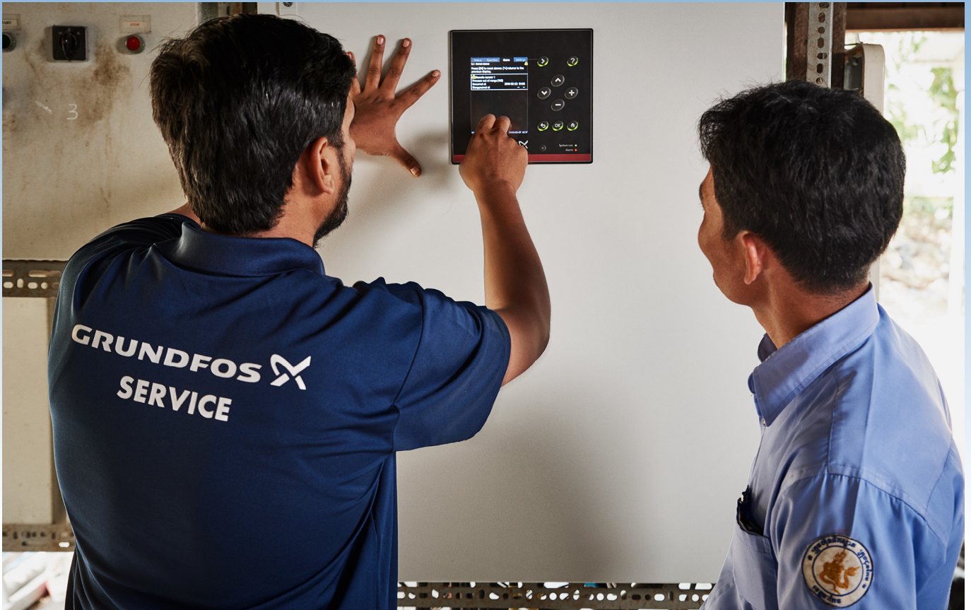
Karthik Balasubramaniam (à gauche) inspecte le coffret de commande CU 354 (cœur du système « DDD ») avec Em Eang, Responsable du réseau de distribution chez Takéo Safe Water Supply.
