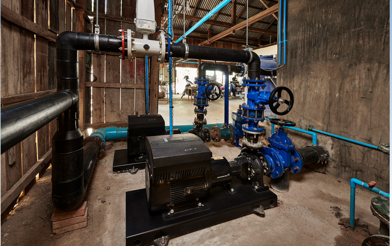
Les pompes Grundfos NKE constituent le pilier du système de distribution pilotée par la demande de Takéo Safe Water Supply au Cambodge.
