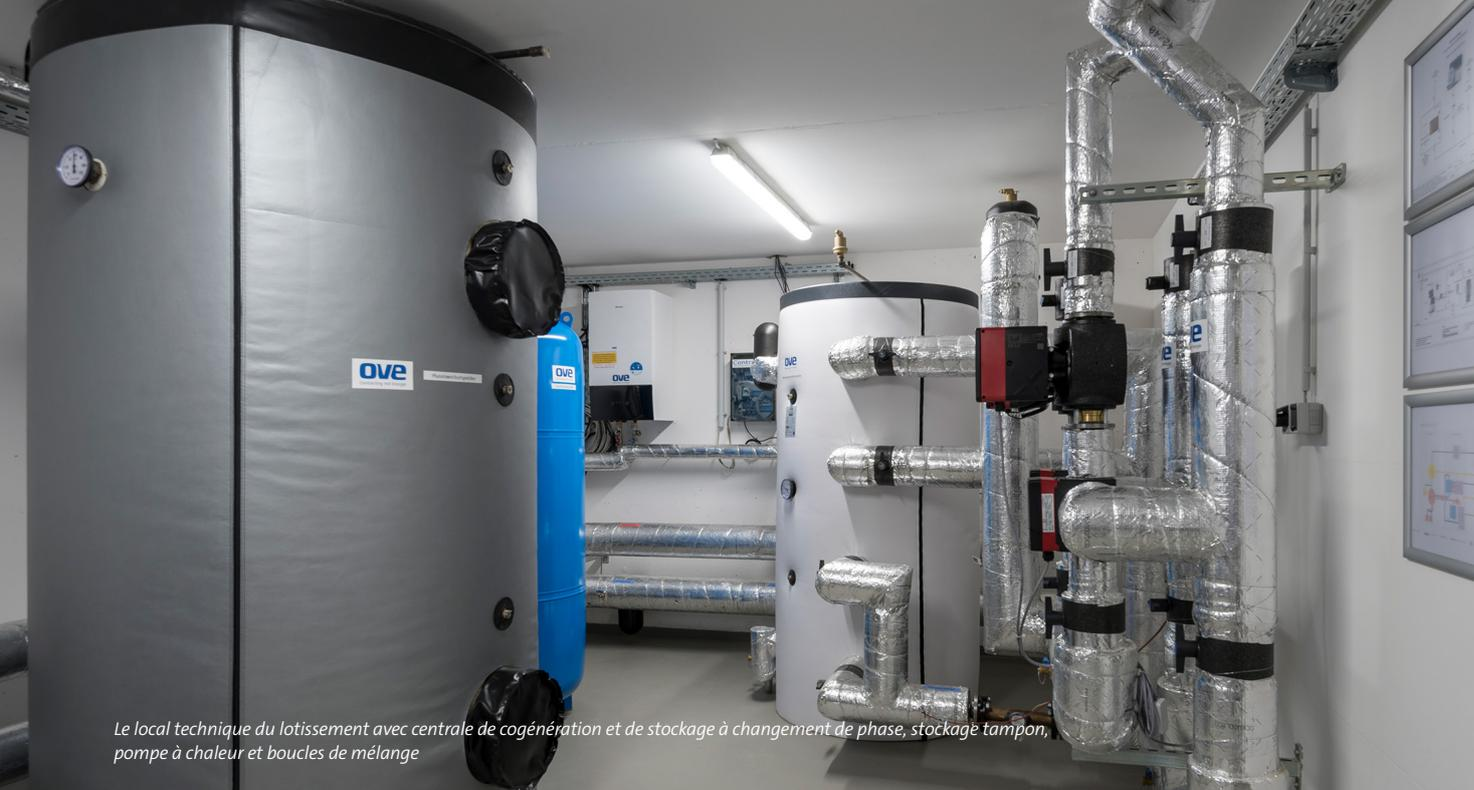
*Le local technique du lotissement avec centrale de cogénération et de stockage à changement de phase, stockage tampon, pompe à chaleur et boucles de mélange*
