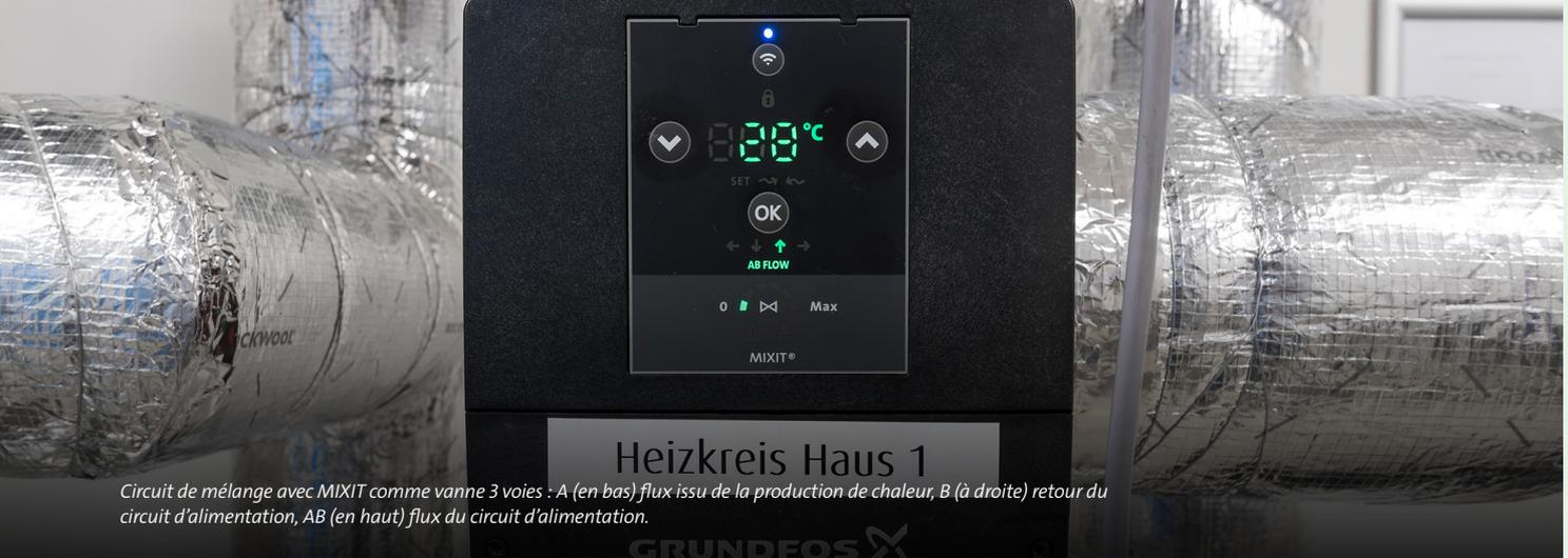
Circuit de mélange avec MIXIT comme vanne 3 voies : A (en bas) flux issu de la production de chaleur, B (à droite) retour du circuit d'alimentation, AB (en haut) flux du circuit d'alimentation.
