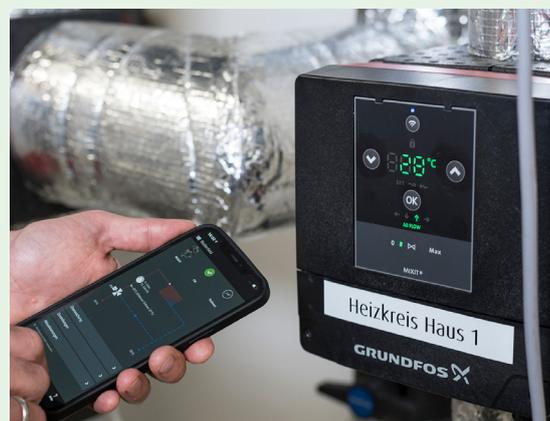
L'interface sans fil permet de mettre en service et de surveiller l'unité de commande MIXIT à l'aide de l'application Grundfos GO Remote.
