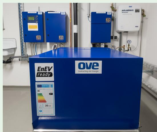
*Le générateur de chaleur principal est un système de cogénération compact avec 21 kW de puissance thermique et 9 kW de puissance électrique.*
