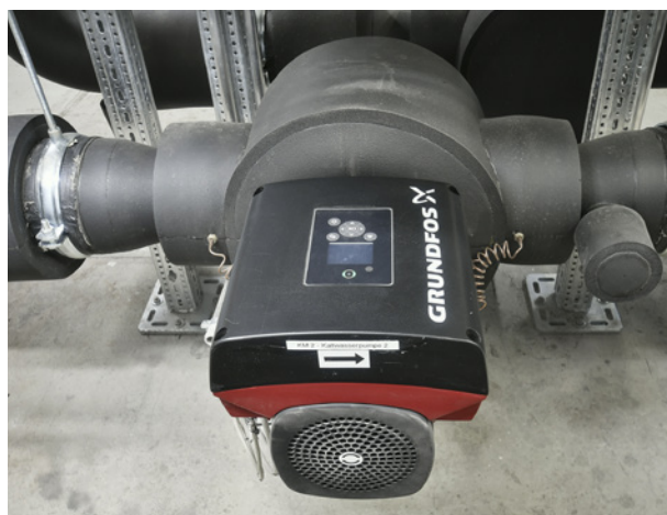
Hocheffiziente Inline-Pumpe der Baureihe TPE
