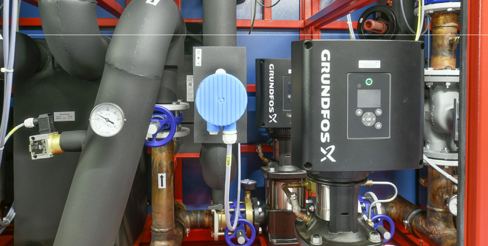
Armaturengruppe des hocheffizienten SEW-Wärmerückgewinnungssystems
