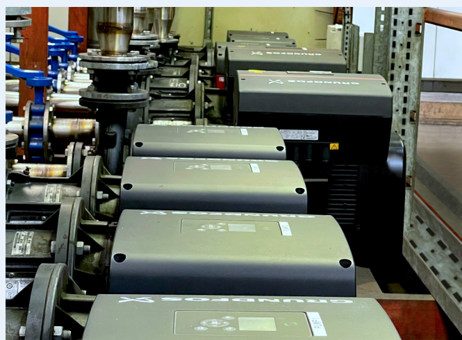
14 Grundfos NBE-anlæg med to pumper og effektive IE5-motorer på 11 kW kører med konstant trykregulering i Lucozades centrale køleanlæg.
