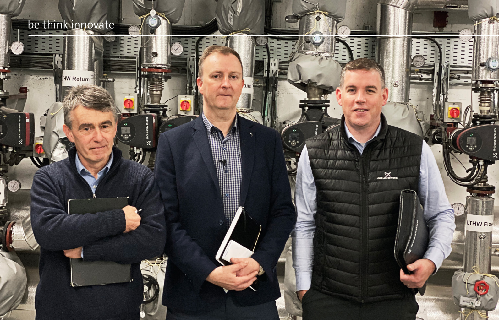
V.l.n.r. Michael O'Brien en Declan McGoldrick van de afdeling VGM van Sligo University Hospital met Liam Kavanaugh van Grundfos Ireland in de ketelruimte van het ziekenhuis.
